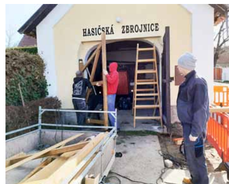
Výměna vrat v hasičárně
