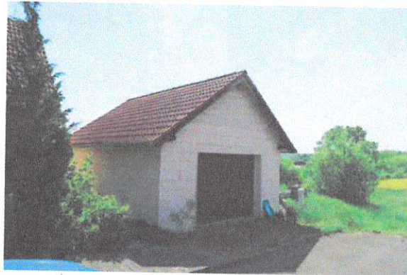
garáž - stavba cizího vlastníka
