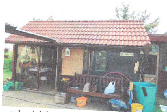
zahradní domek - stavba cizího vlastníka
